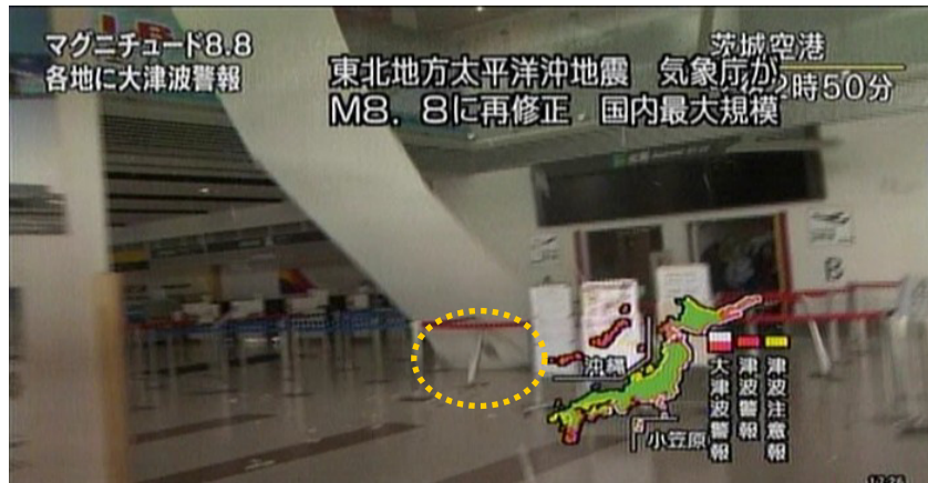
図1 落下した天井の最初に接地した部分
