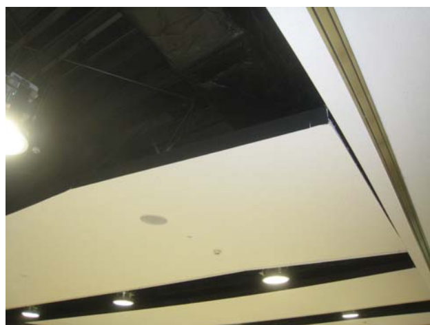
図 19 変形した天井（図 10 の③列）
