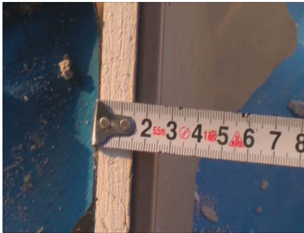
図 23 落下したロックウール化粧吸音板
