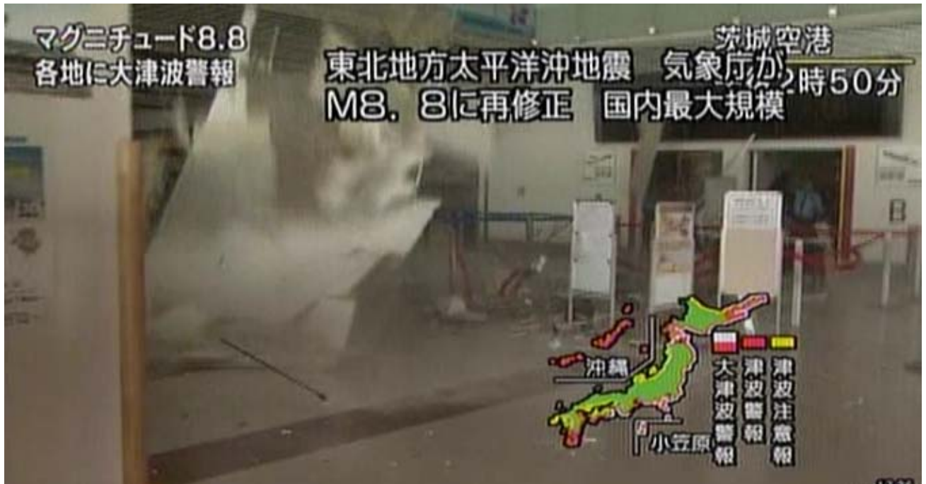
写真 NHK14 (10.3 s) : 天井西端部は先に落下した部分に逆に覆いかぶさるように落下している。手前に黒く塗った吊ボルトがクランプ金物とともに落下している。ハンガー金物等は付いてない。
