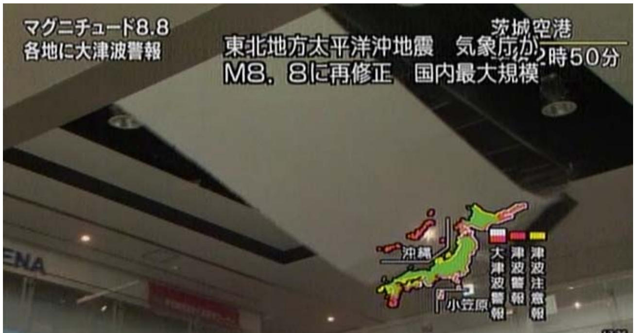
写真 NHK10 ( 8.1 s ) : 南側長辺も一気に落下。南側長辺のダブル野縁は下地に残っており、この部分はビスの頭抜けによる落下であることがわかる。南東の段差部も一緒に落ちている。
