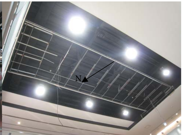
図 7 天井落下箇所(Nは北方位)
