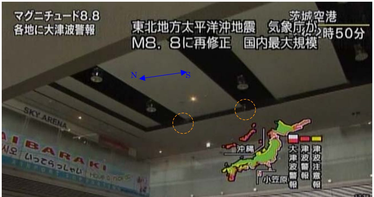
写真 NHK3 (3.5 s) : 照明は短い周期で主に南北方向に揺れているように見える。天井も段差部にこすりつけられるように主に南北方向に繰り返し揺れているように見える。
