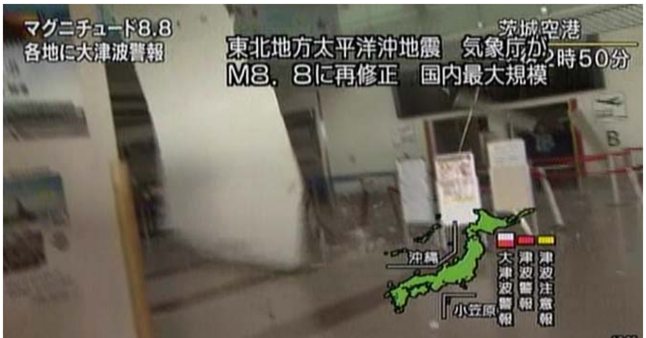
写真 NHK13 ( 9.9 s ) : 床に到達した部分から粉々に脆く破損していく。
