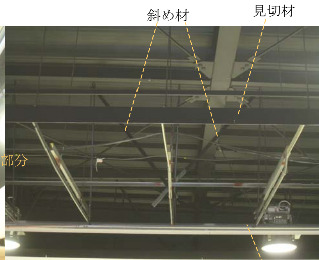
図 16 長手方向天井下地 見切材
