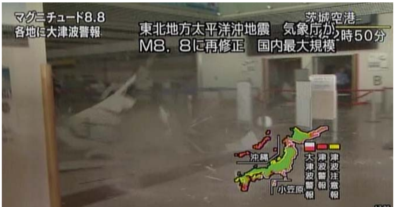
写真 NHK15 (10.7 s) : 石膏ボードによる脆い破壊が見られる。
