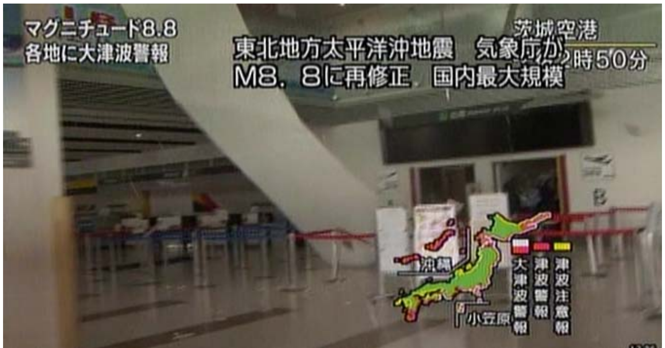
写真 NHK12 ( 9.5 s ) : 端部が床に達する。最西部の天井はまだ上部にとどまっている。この部分は画面左のずっと上であるが、野縁が残り、ビスの頭抜けになって落下しているの、落下が追いつくのに遅れがある。最西部は吊りボルトが無いので、この時、最西部の野縁受けを支点として、端部がかなり跳ね上がるような挙動をしていると推測される。
