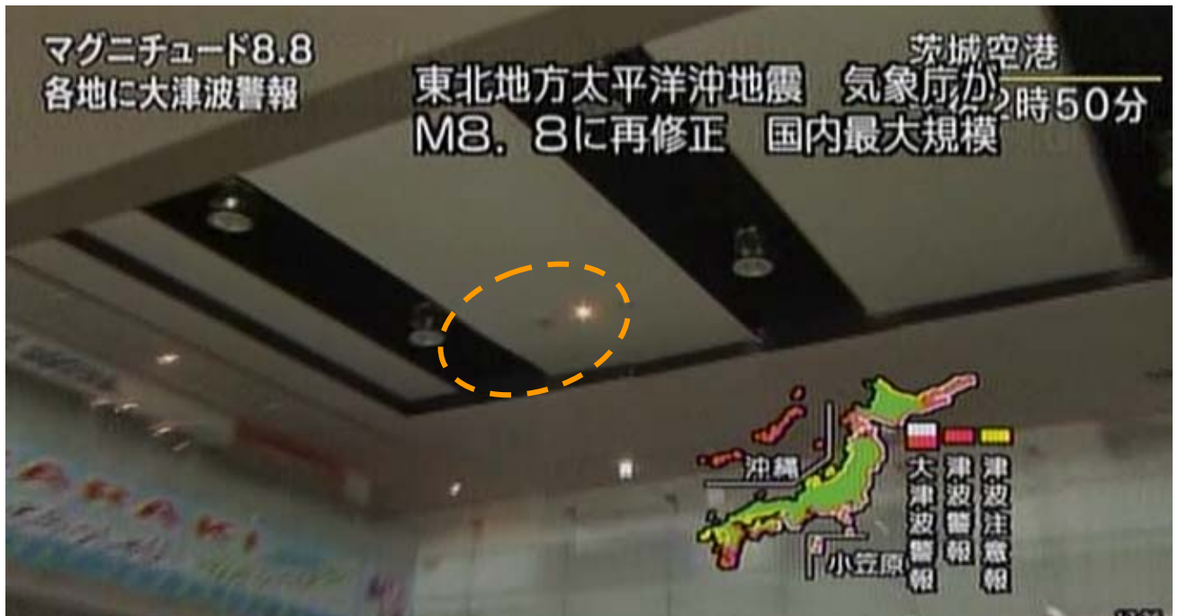
写真 NHK4 (5.3 s) : スピーカー及び非常灯が並んでいる部分を起点とするように、天井北側の長辺において天井材の面外への折れ曲がりが見える。
