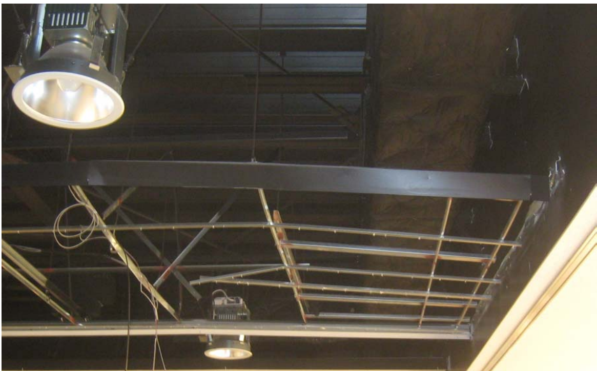
写真 3：西端の見切り材端部。手前の北側の方が変形も大きく、照明の脇で捩じれ座屈的な変形も生じている。段差部と当たった痕跡も強く残っている。
