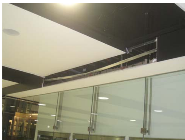
図 21 段差部の落下跡（図 10 の⑤列）
