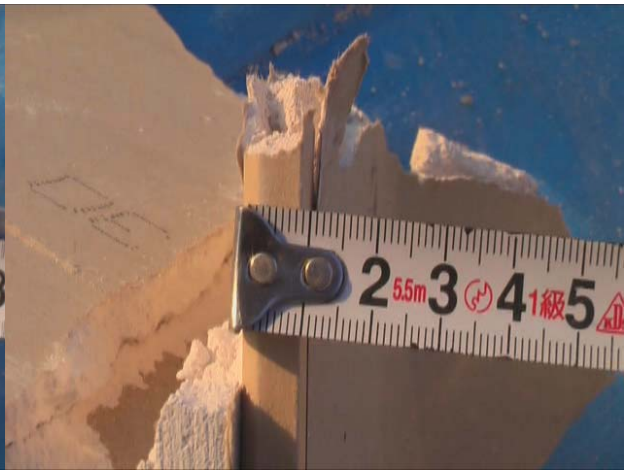
図 24 落下した捨て張り石こうボード
