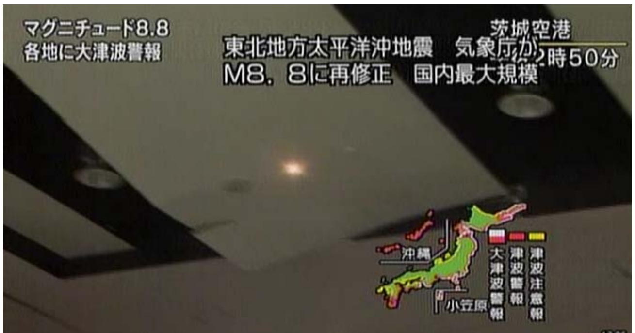
写真 NHK7 (6.6 s) : 折れた箇所より東側、天井材の継ぎ目あたりで天井材が裂けはじめる。南側長辺は下がらずに、北側のみ端から落ち続ける。北側長辺のダブル野縁も落ちていたことから、これらの落下は主にクリップが外れたことによるものと考えられる。
