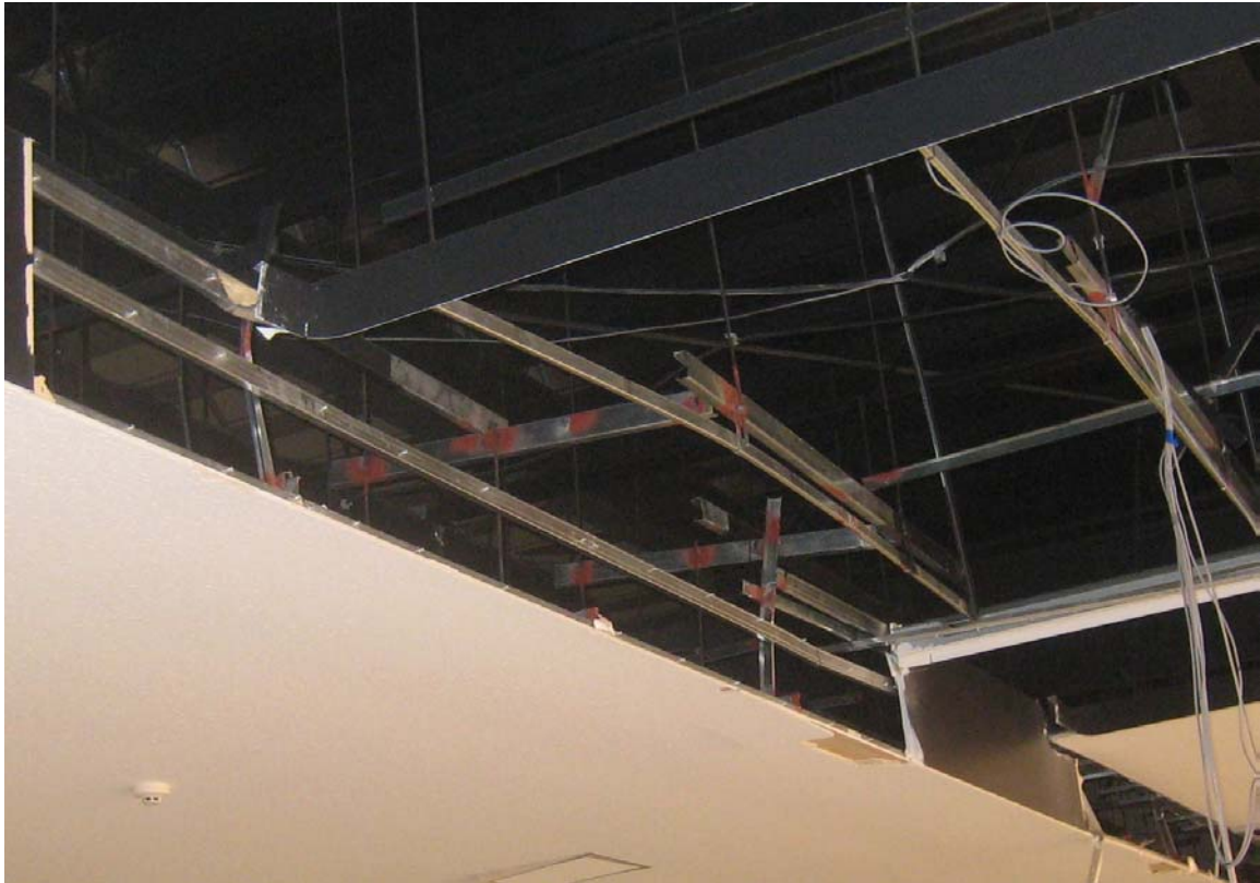
写真 2：東端見切り材端部。手前の北側の方が変形も大きい。
