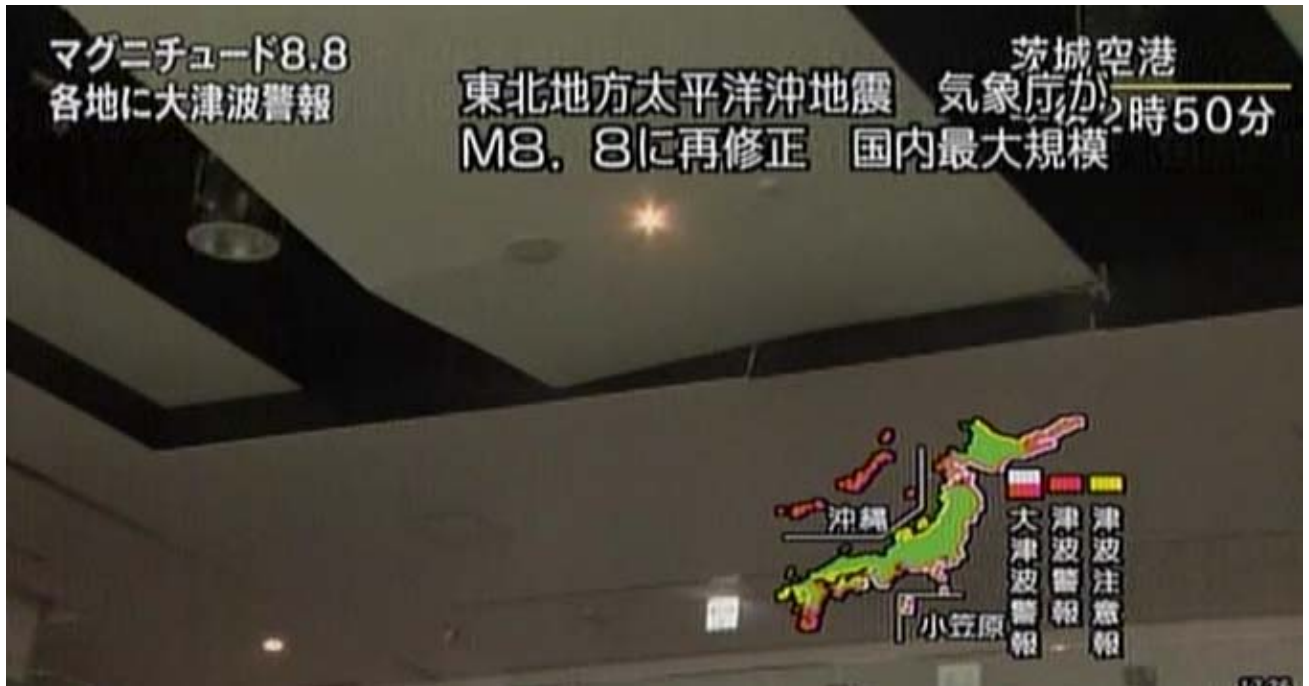
写真 NHK6 (5.9 s) : スピーカーのラインは天井の欠損が多いため、これに沿って天井材が折れるとともに、北東隅部が下がり始める。天井の変形状況から考えると、この時点では北東の角付近のクリップはほとんど外れている可能性が高い。上記の平行四辺形の変形に起因するのではないだろうか。
