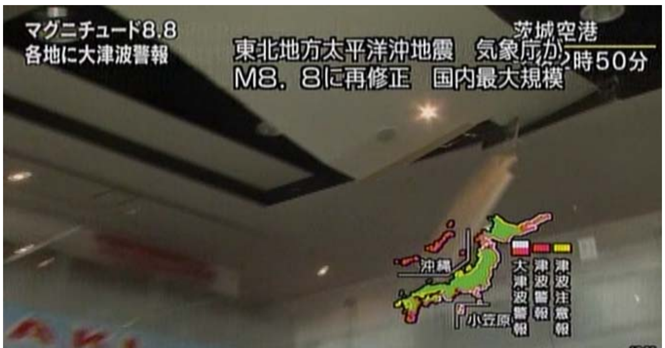
写真 NHK9 (7.5 s) : 裂けた天井材片が落下している。段差部寄りに、野縁材が2本ほどみえるため、先に落下中の天井材片は石膏ボードがビスの頭抜けをしていることがわかる。この時点で、天井全体が北東隅部からはっきりと落下状態になっている。南辺部分もたわみだしている。
