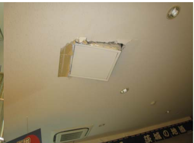
図 27 排煙ダクト口
