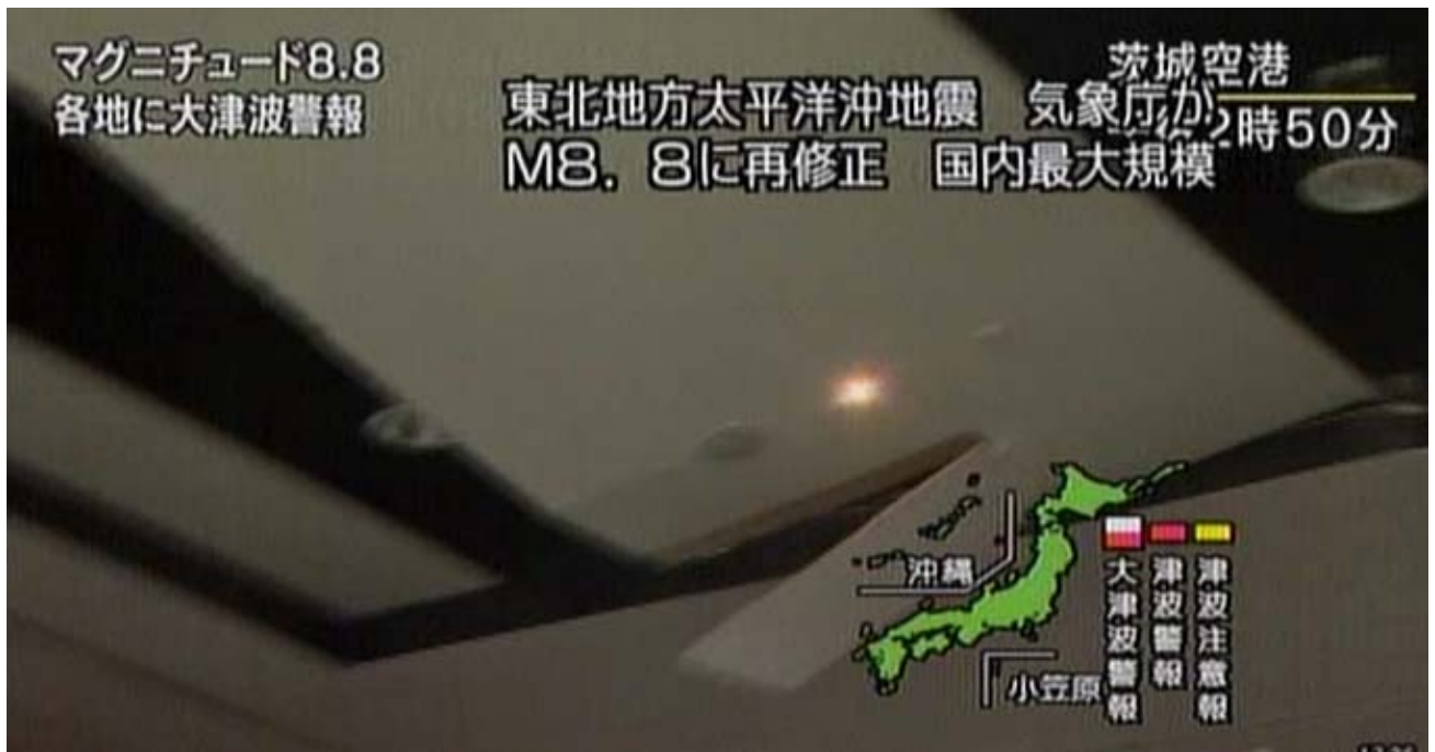
写真 NHK8 (7.1 s) : 裂け目から石膏ボードの余りが見える。仕上げの破損線はロックウール吸音版の継ぎ目に沿っているようだ。
