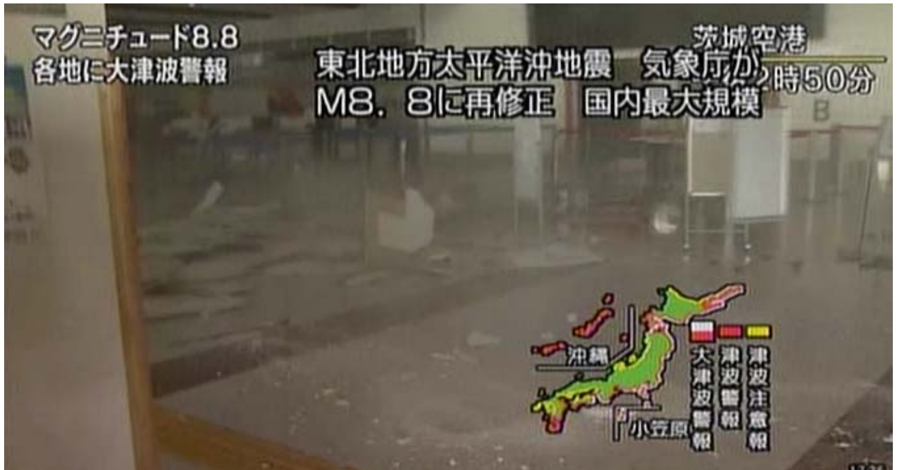
写真 NHK16 ( 11.3 s ) : 石膏ボード下地の破損に伴う埃と残骸が散らばっている。
