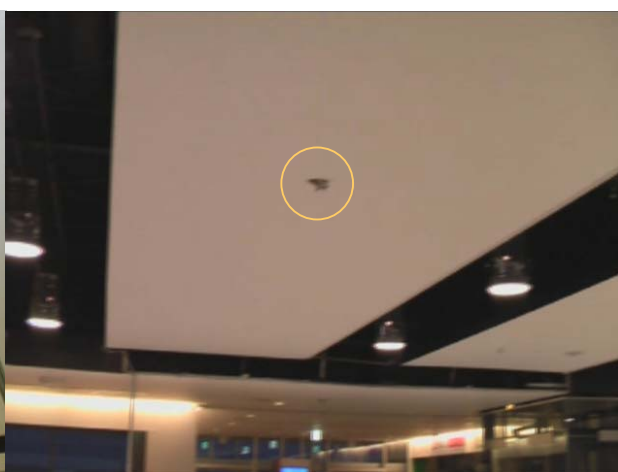
図 20 天井面の穴（図 10 の②列） （点付け溶接が外れた下地材が貫通しかけているのだろうか。）
